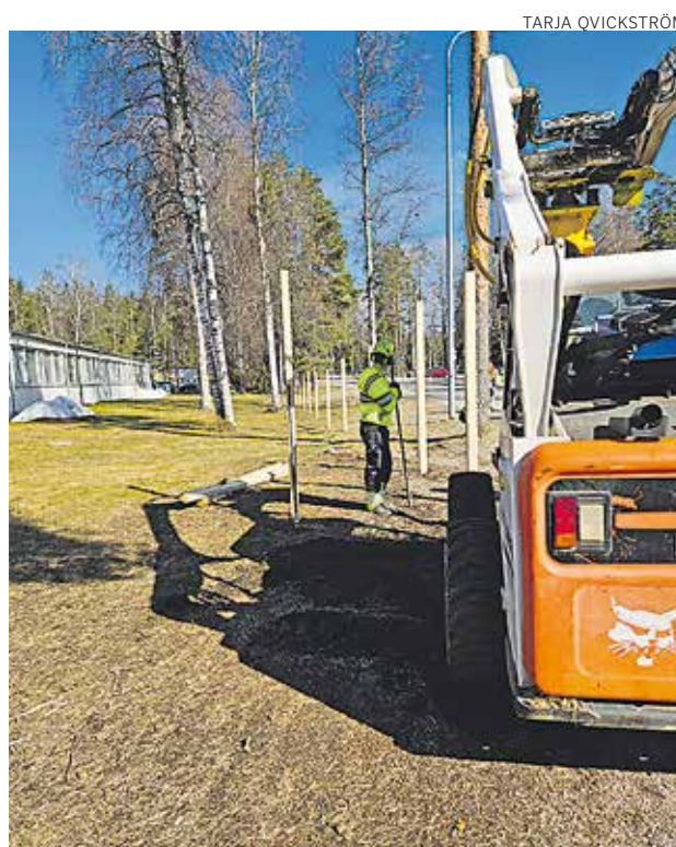
Työmaan perustaminen on jo itsessään mittava projekti, Stefan Lindholm sanoo. Tässä on alkamassa suoja-aitojen pystytys.
