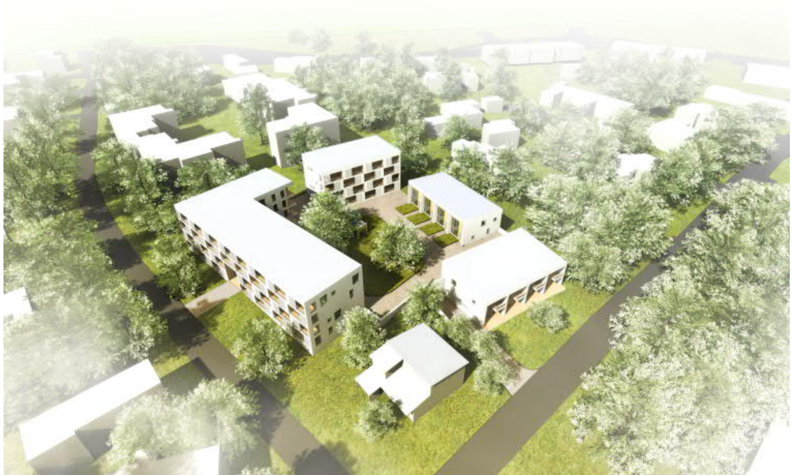
Kuva 10. Näkymä ilmasta (L-Arkkitehdit, 16.1.2018).
