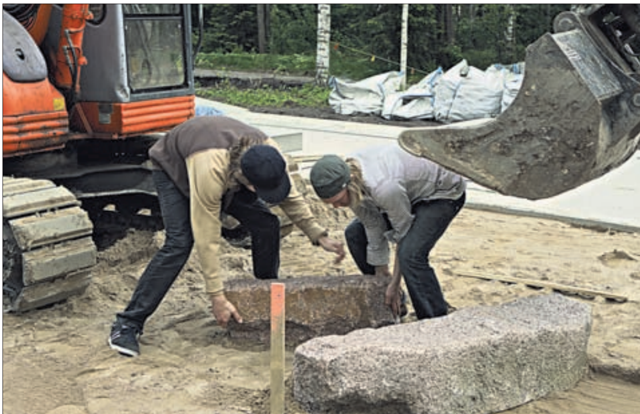
Kivipaasia jouduttiin siirtämään paikoilleen käsivoimin. Koneista ei tähän hommaan ollut apua. Stenstoderna måste flyttas för hand för att sitta rätt. Här hjälpte inte några maskiner.
