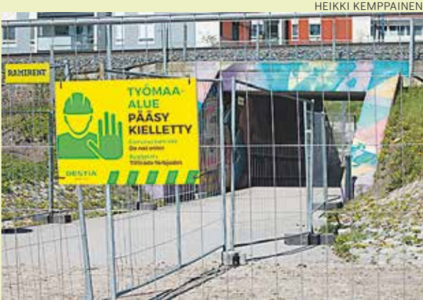
Yhtiöntien alikulku on käytössä myös kesällä, vaikka työmaa-alue on tarkoin rajattu. Fotgängartunneln vid Bolagsvägen är öppen hela sommaren men byggplatsen är inhägnad.
