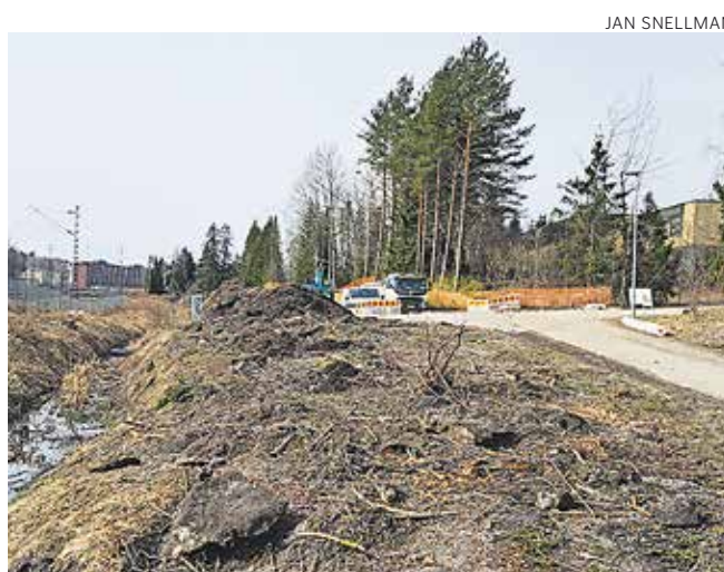
Työmaa Palokunnankujan kohdalla 10.4. Byggarbetsplats vid Brandkärsgränden 10.4.
