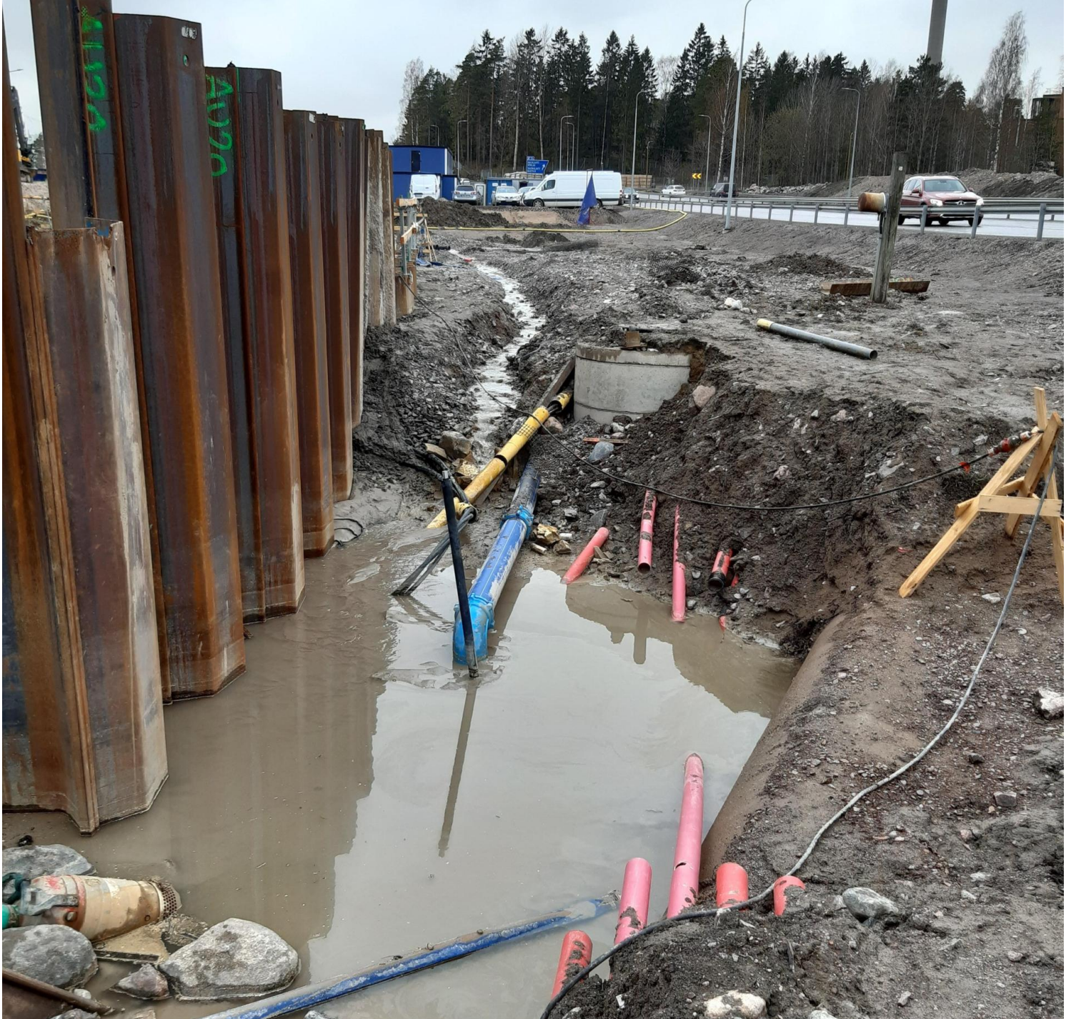
Kuva 3: Työmaakaivanto, jossa pumppu. Kuvaaja Saara Olsen.
