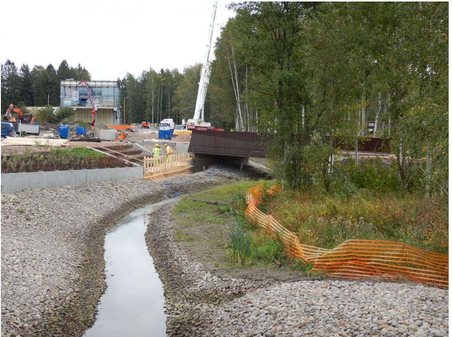
Kuva 1: Työmaa, jossa uoman penkat on eroosiosuojattu ja uoman varrelle jätetty maata sitovaa ja huuhtoutumista estävää kasvillisuutta. Saara Olsen
