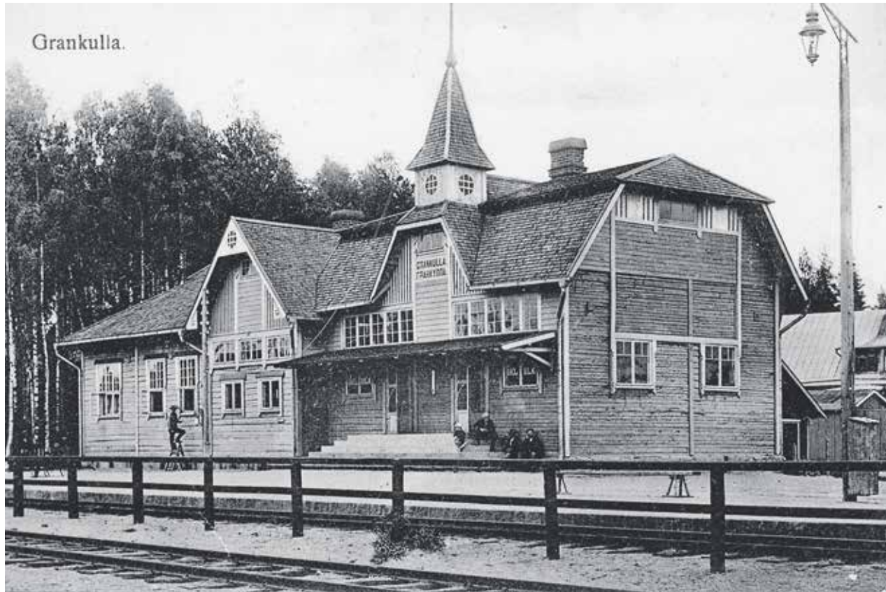
Rautatieasema noin vuonna 1910. Hirsii ei ollut vielä verhoiltu laudoilla. Venäläinen nimi löytyy tekstin Grankulla alapuolella. Järnvägsstationen ca 1910. Stockväggarna är ännu inte brädfodrade. Det ryska namnet finns under texten Grankulla.
