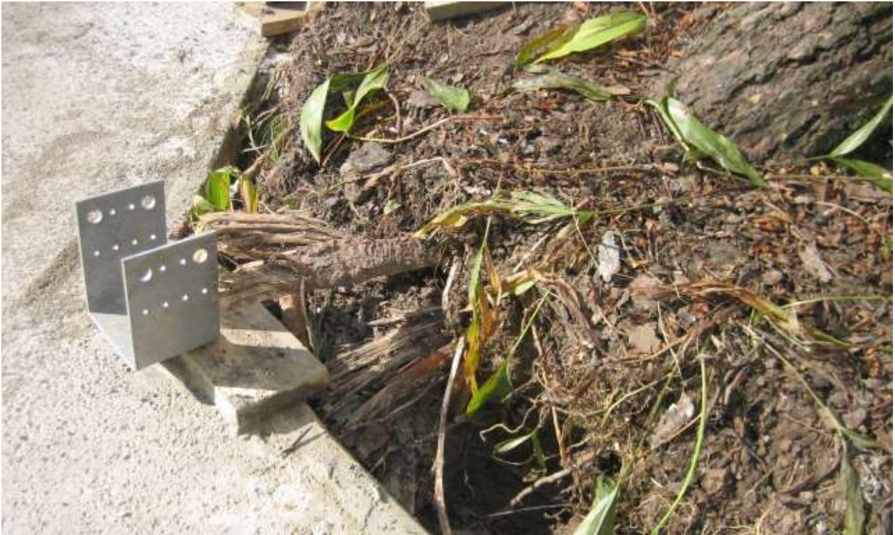
Obehandlade tallrötter som skadats i samband med byggarbeten. Bild: Minna Aavalehto 2009.
